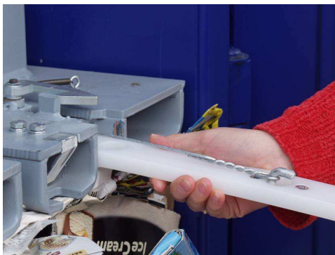
Bild 5-14 Einschieben des Drahtziehhakens
