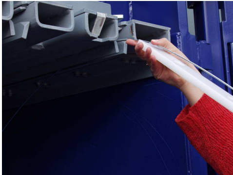
Bild 5-13 Ansetzen des Drahtziehhakens
