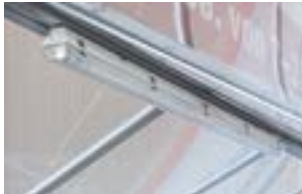
Innenbeleuchtung Wetterfeste Ausführung mit 58 Watt Leuchtkörper.
